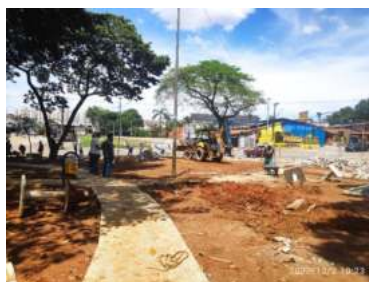
Imagens 15: Chegada do Material, bloquetes e pedriscos
