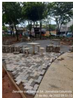
Imagens 17: Pavimentação de bloquetes na área central
