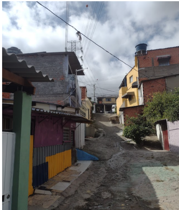
Fig. 4 - Características construtivas em alvenaria no Jd. Cumbica II
