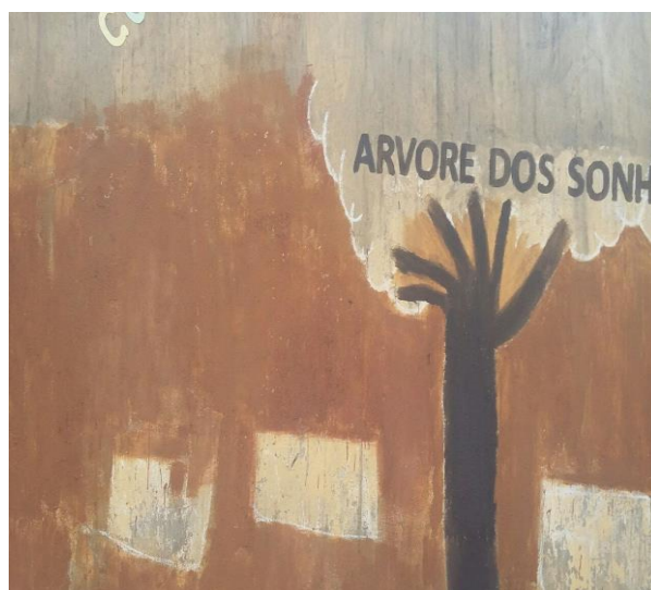
Imagem 04: Pintura parcial do muro com tintas de solo.
