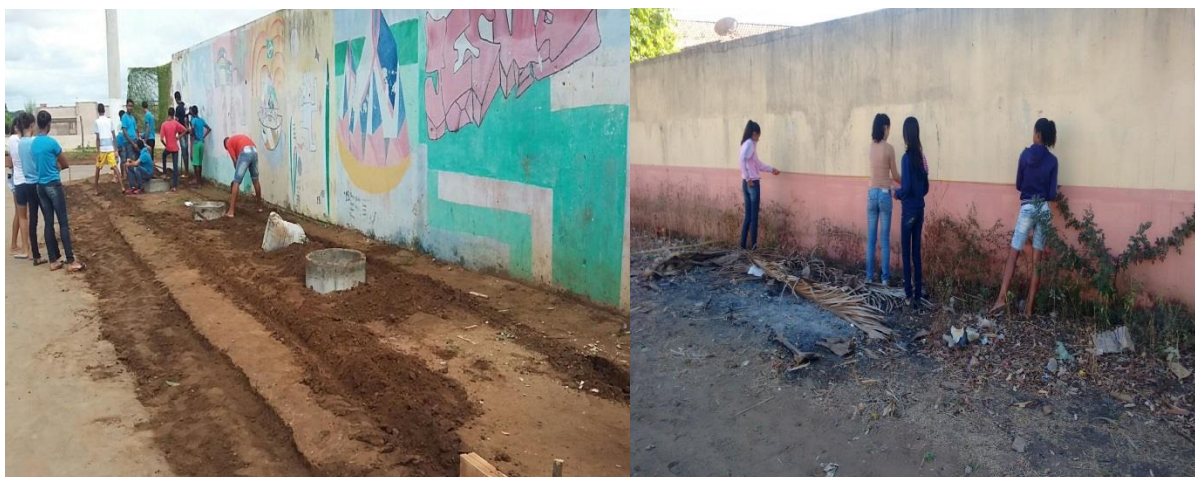
Figura 10: Processo de construção da calçada permeável. Fonte: QUEIROZ, S. T. M.
